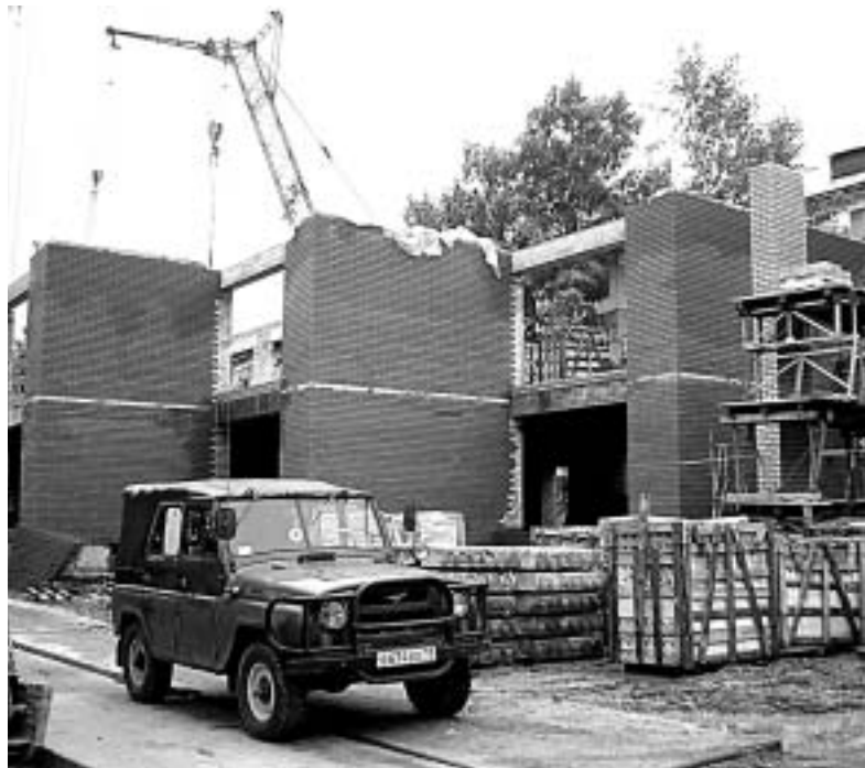
Строительство одного из корпусов комплекса близится к завершению.
